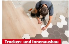
Trocken- und Innenausbau
